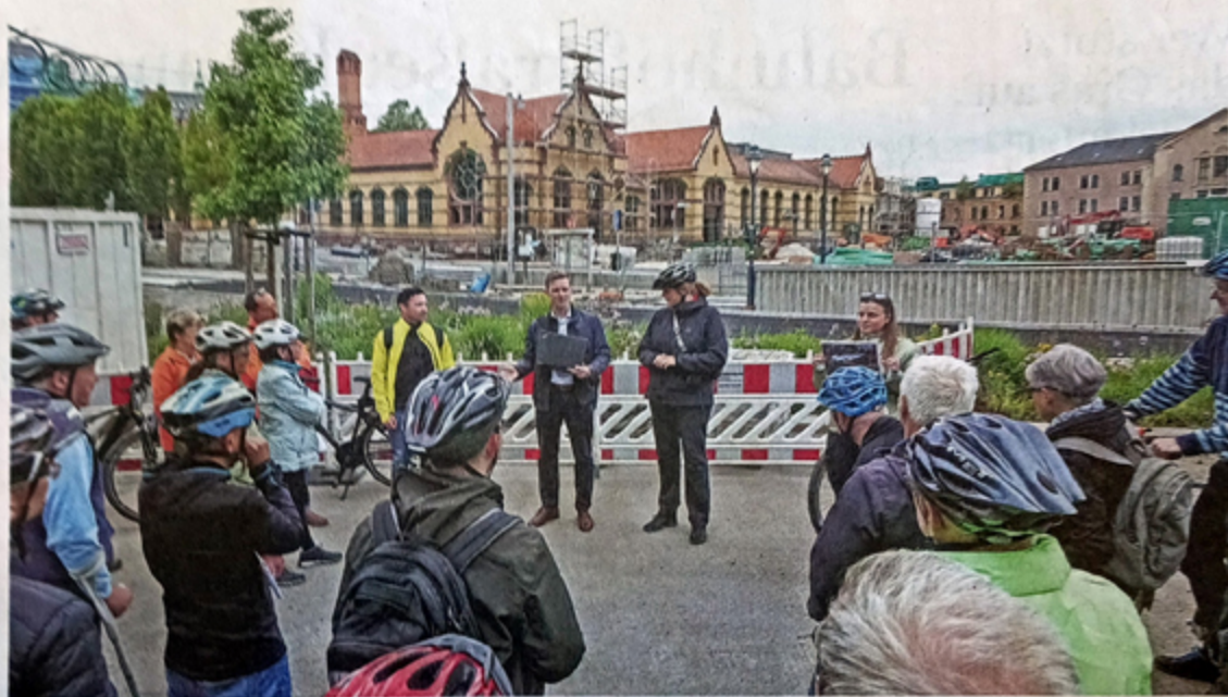
Aus dem ehemaligen Zwickauer Krankenkopf wird ein Rewe-Markt. Infos zum Umbau, zur Verkehrslösung und zum Eröffnungstermin gab es bei der Einwohnerversammlung auf Rädern mit Oberbürgermeisterin Constance Arndt (BfZ).
